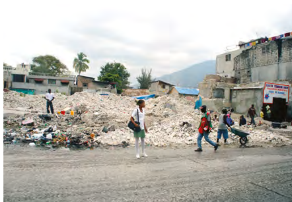
Le déblaiement 15 mois après le séisme. Crédit photo : Claire Zanuso, 2011.
