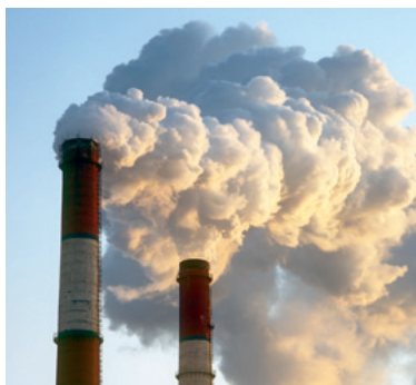
Pollution atmosphérique due aux microparticules émises par des fumées © : SBBA
