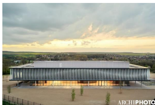
Figure 1. Photographie du bâtiment de l'institut FAIRE FACES
