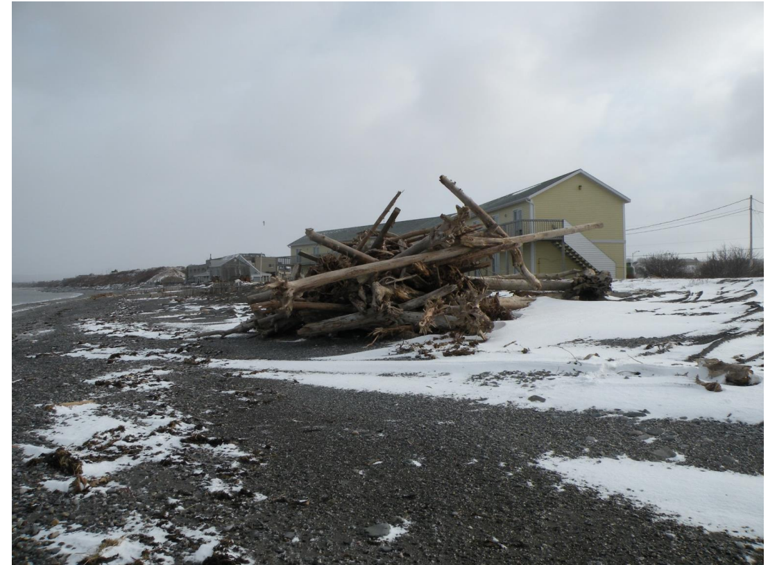
Matane-sur-Mer, après la tempête de janvier 2018 (LDGIZC)
