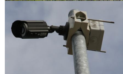
Sécurisation du site
