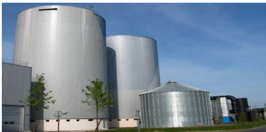
Vue des deux réacteurs VALORGA de l'usine de traitement des déchets de Varennes-Jarcy (France)
